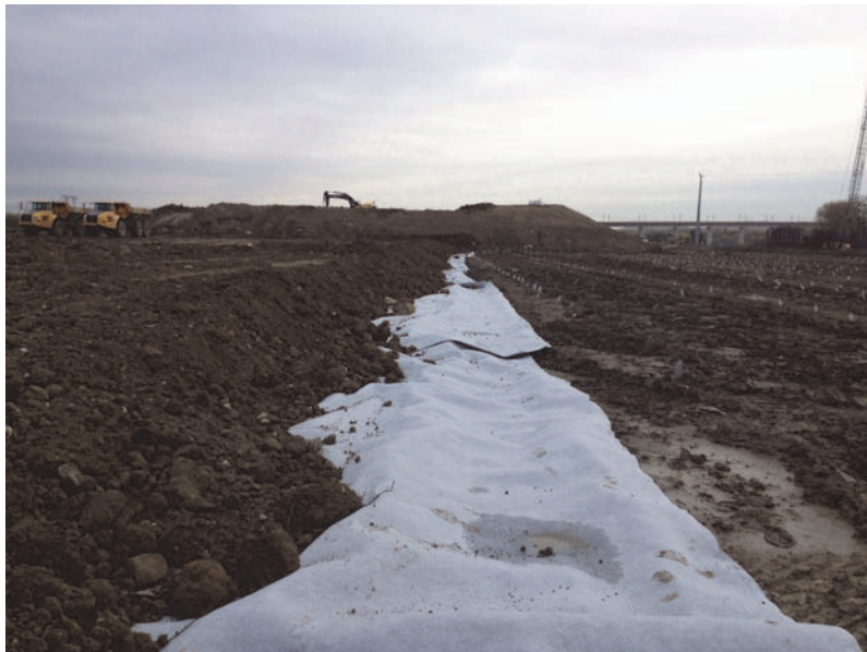
Figure 7: Longueuil Sainte Marie (60) – mise en œuvre du remblai sur le géocomposite de drainage
