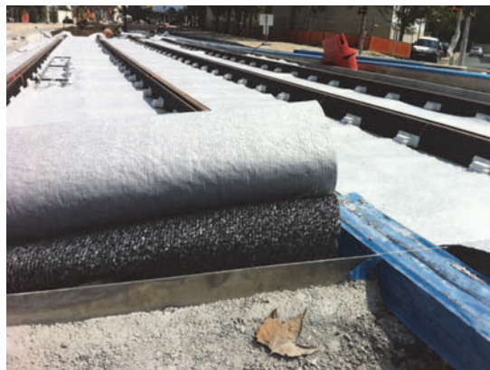
Figure 2. Géocomposite de drainage sous voie de tramway
