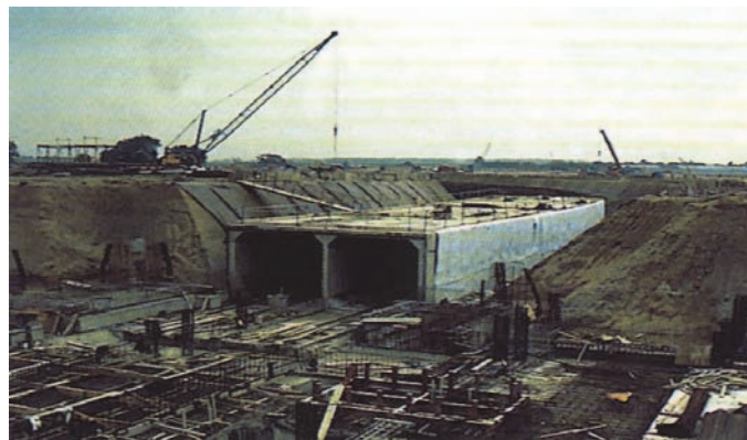
Figure 3. Géocomposite de drainage sur les parois verticales d'une galerie technique
